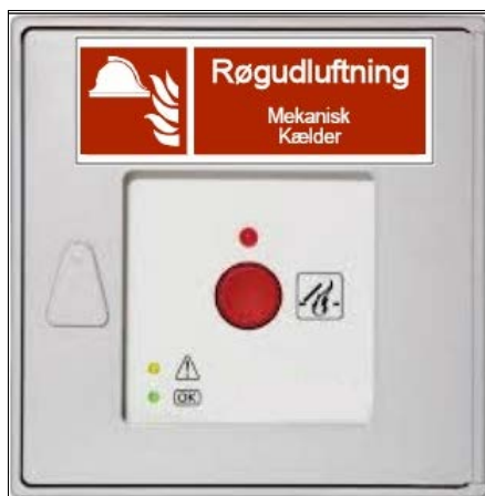
Figur 5.8.4.a: Eksempel på aktiveringstryk for røgudluftning
