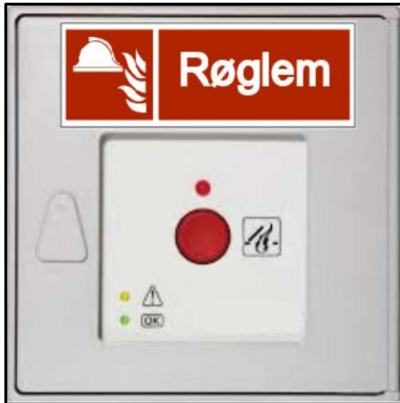
Figur 5.11.1 Eksempel på aktiveringstryk for røglem.
