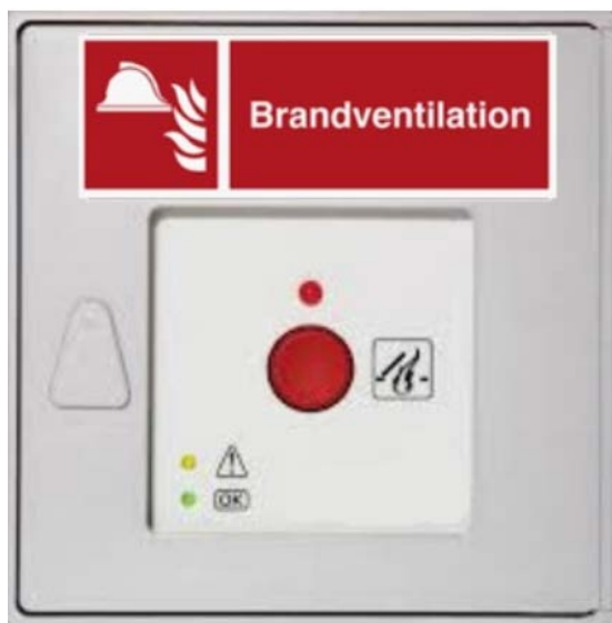
Figur 5.8.1 Mærkning af manuelt aktiveringstryk for ABV-anlæg.
