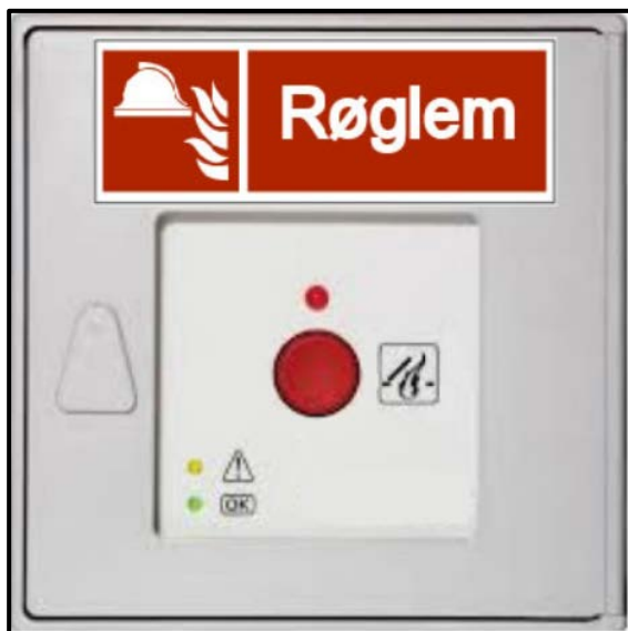
Figur 5.11.1 Eksempel på aktiveringstryk for røglem.
