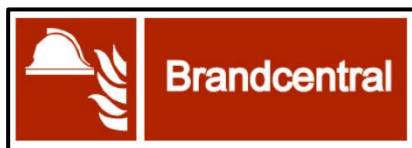
Figur 5.13.1 Eksempel på markering af adgangsdøren til brandcentral.
