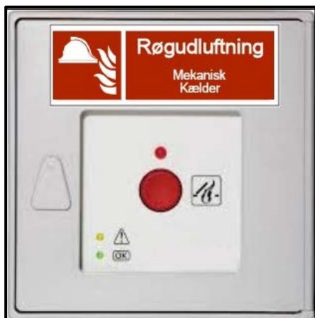
Figur 5.8.4.a: Eksempel på aktiveringstryk for røgudluftning.
