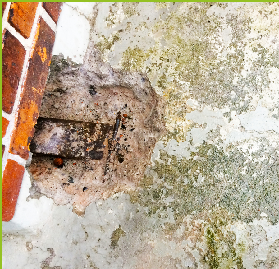
Figur 8: Ophugning til udliggerjern foretaget ind under facade til besigtigelse af jernets tilstand i området under facademuren.
