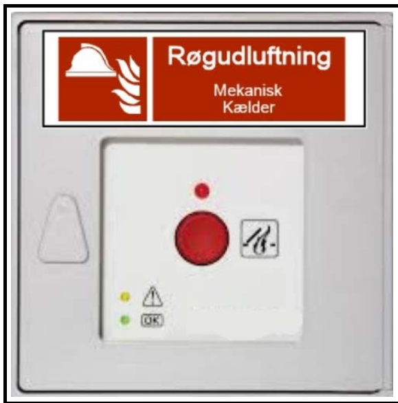
Figur 05.11.05: Eksempel på aktiveringstryk for røgudluftning
