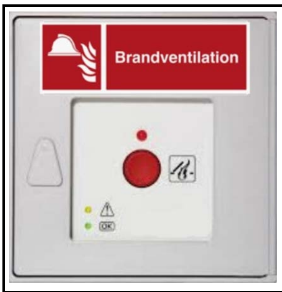
Figur 05.08.01: Mærkning af manuelt aktiveringstryk for ABV-anlæg
