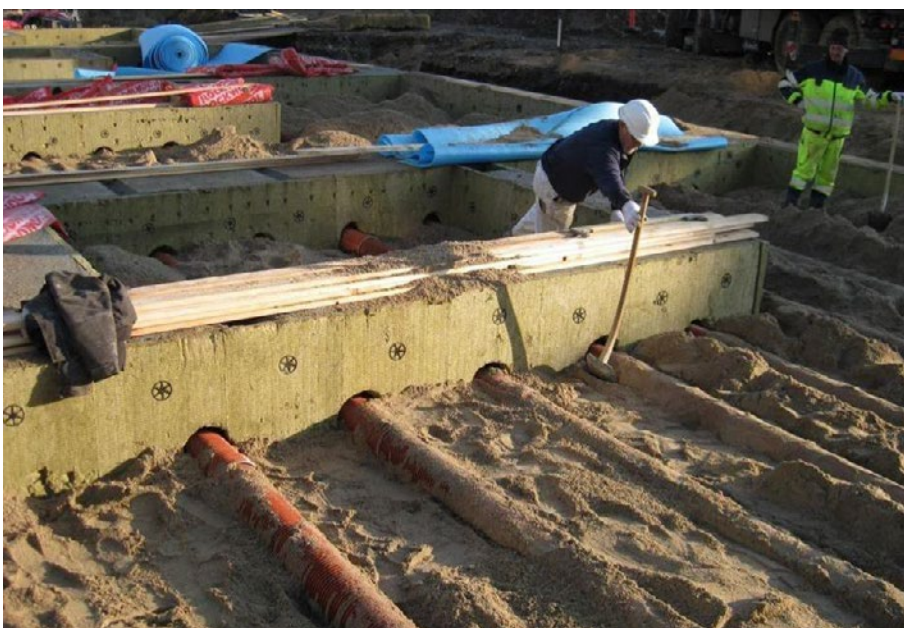
Figur 19. Etablering af kanaler under bygningen. (Bo Christensen)
