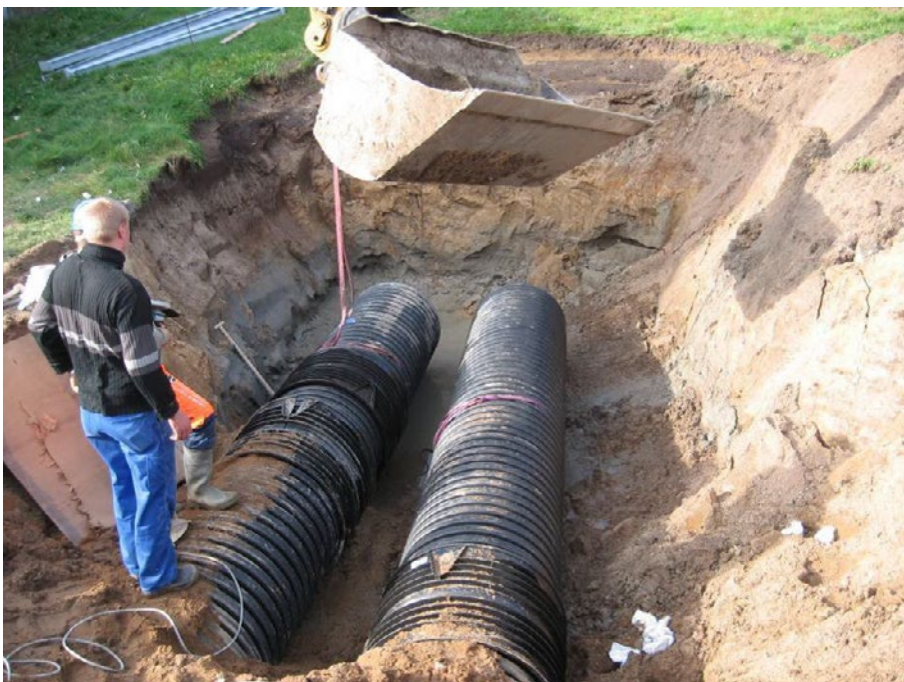
Figur 31. Fotoet er taget under etablering af kanalerne i jord. (Leif Nielsen)
