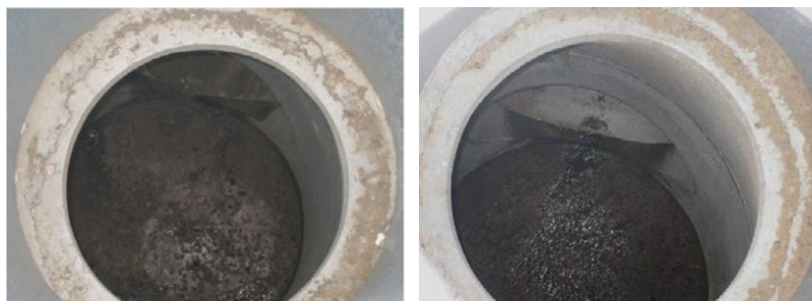
Figur 27. Kig ned i fraluftkanalen til venstre og indtagskanalen til højre.
