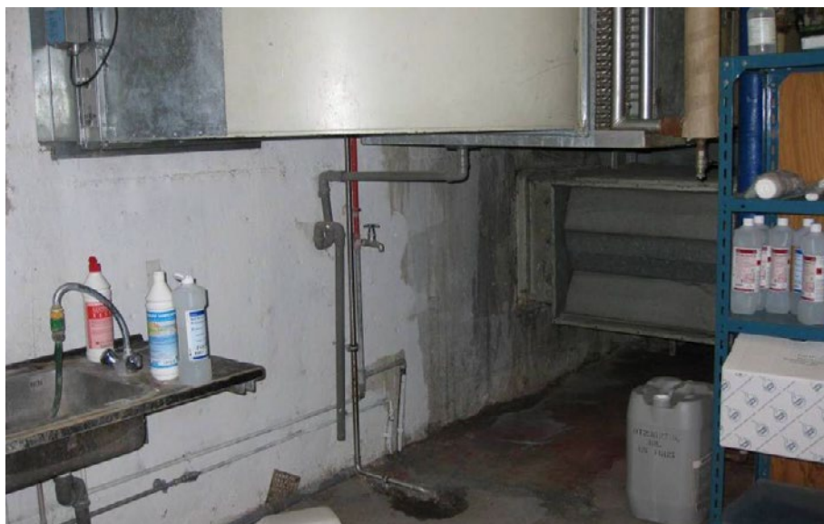
Figur 50. Indtagskanalens udmundning i ventilationsrummet i kælderen. Kanalen udmunder bag det lukkede spjæld til højre.
