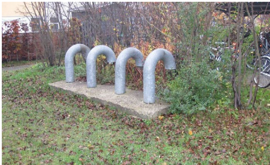
Figur 58. Østside. Udeluftindtag.
