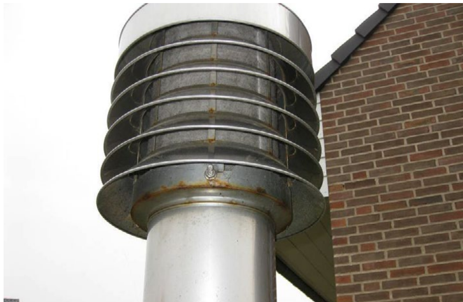
Figur 73. Filter i udeluffindtag.
