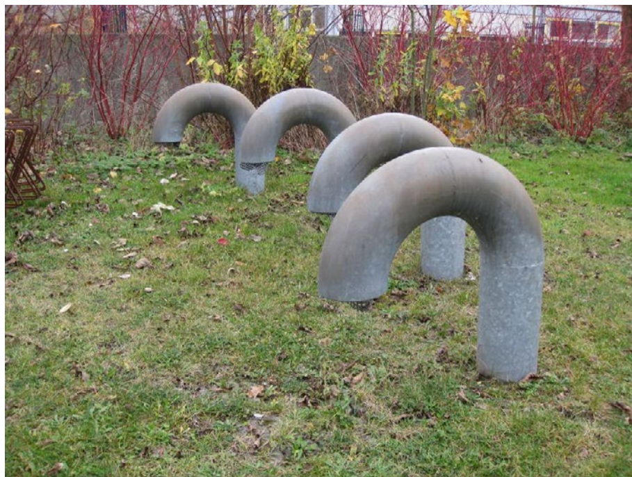
Figur 69. Vestside. Udeluftindtag.
