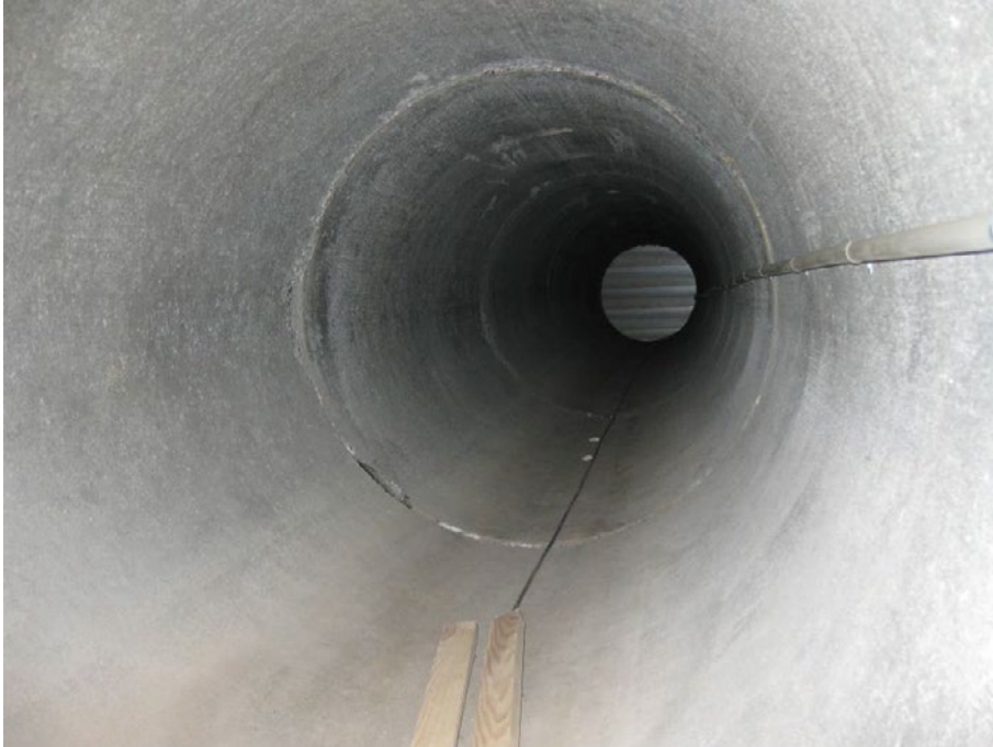
Figur 38. Indtagskanalen under bygningen set inde fra kælderen.
