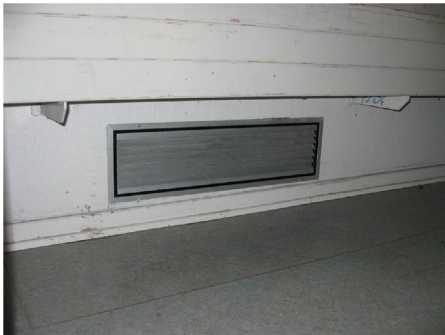
Figur 64. Tilluftsrister i klasserum.
