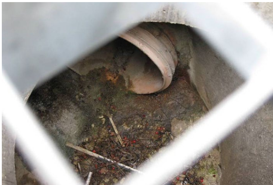
Figur 49. Kig ned i indtagskanalen.
