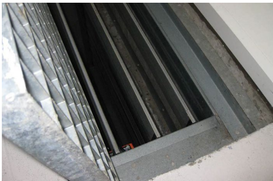
Figur 36. Spjæld i indtagsristen i dobbeltfacaden. Der kan vælges mellem at tage udeluft ind gennem indtagshætten (figur 34), gennem risten i dobbeltfacaden (figur 35) eller en kombination.
