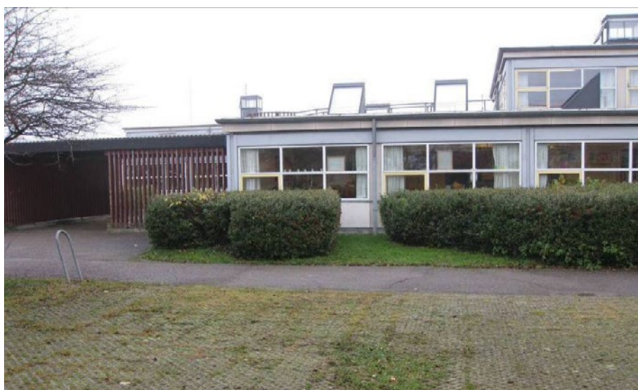
Figur 60. Østside. Kanalerne i jorden går ind til bygningen her. Inspektionsbrøndene (se figur 59) er til venstre umiddelbart uden for billedet.
