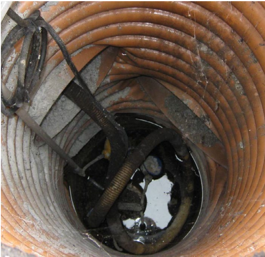
Figur 67. Østside. Én af inspektionsbrøndene. Kanaltilgangen "fra NV" er forbundet med udeluftindtagene, se figur 58 og figur 68. Kanalafgangen "mod NØ" er forbundet med kanalerne i krybekælderen, se figur 61. Slangen i kanaltilgangen "fra NV" er afløb fra dykpumpen i bunden af brønden. Slangen udmunder i ét af udeluftindtagene, se figur 68.
