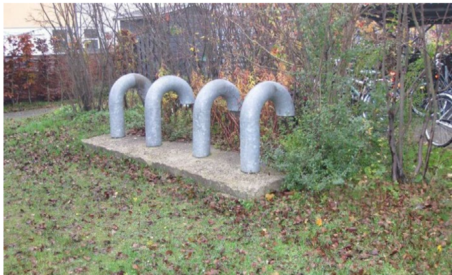
Figur 58. Østside. Udeluftindtag.
