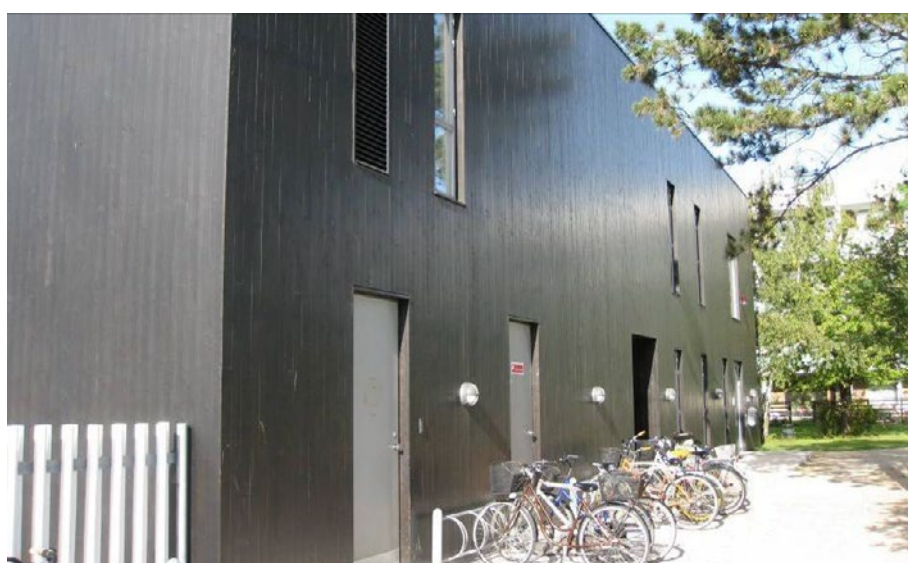
Figur 15. Bygningens facade mod øst. Kondensbrønden er omtrent under cyklen med den gule sadel. Midt i billedet i stueetagen ses dør til sprinklercentral. Teknikrummet er på 1. sal over sprinklercentralen.
