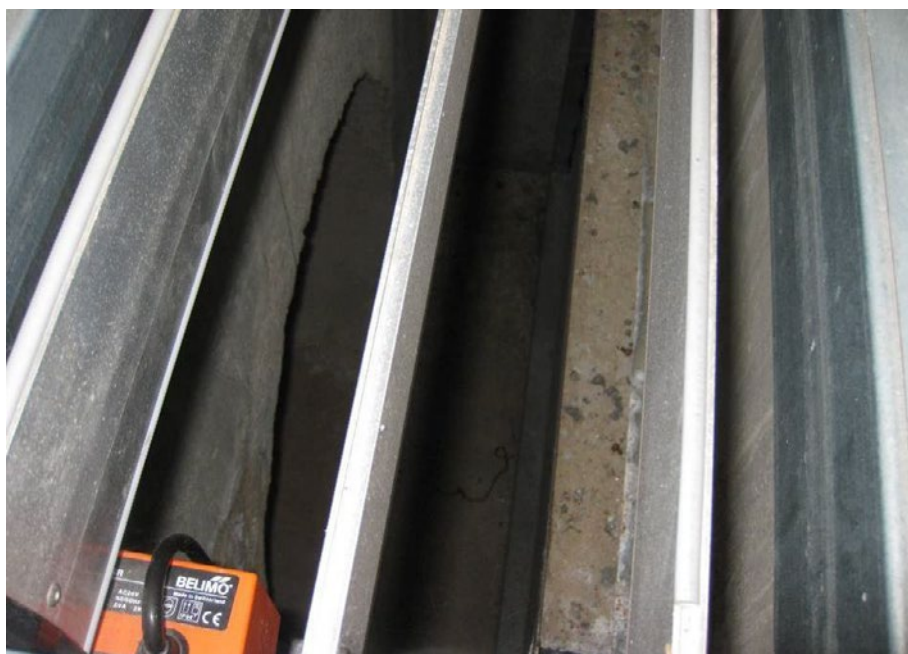
Figur 37. Kig gennem risten i dobbelfacaden til begyndelsen af indtagskanalen under bygningen.
