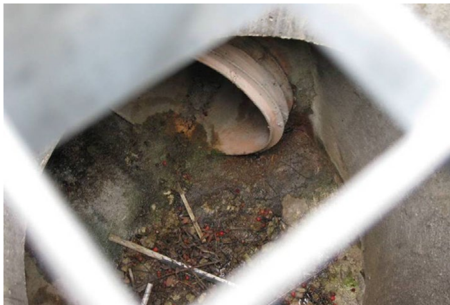
Figur 49. Kig ned i indtagskanalen.
