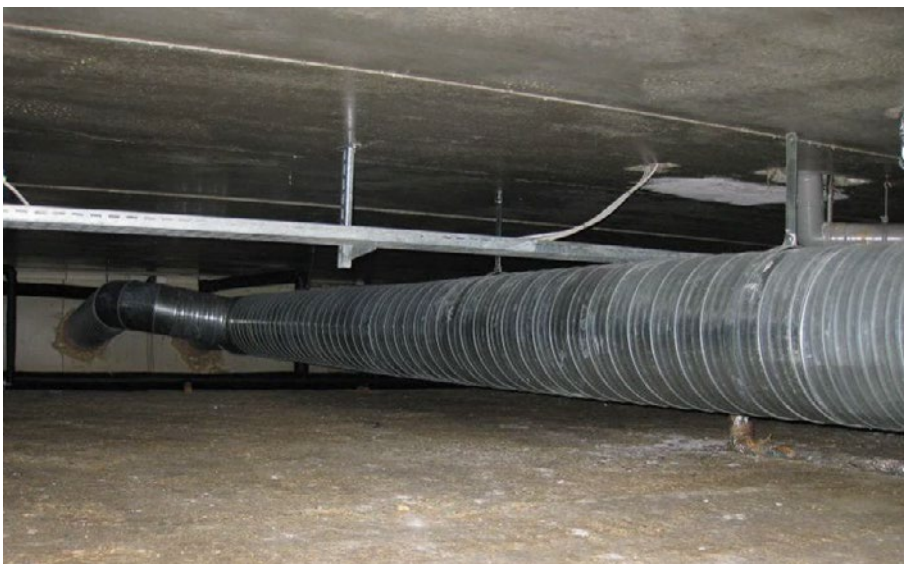
Figur 62. Krybekælder, kanaler i krybekælder.
