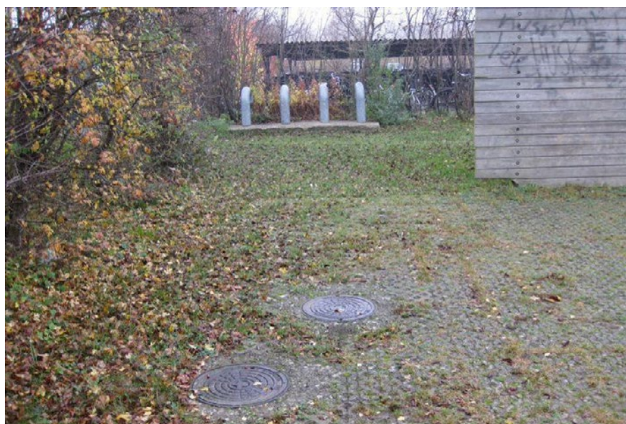
Figur 59. Østside. Inspektionsbrønde i forgrunden og udeluftindtag i baggrunden.
