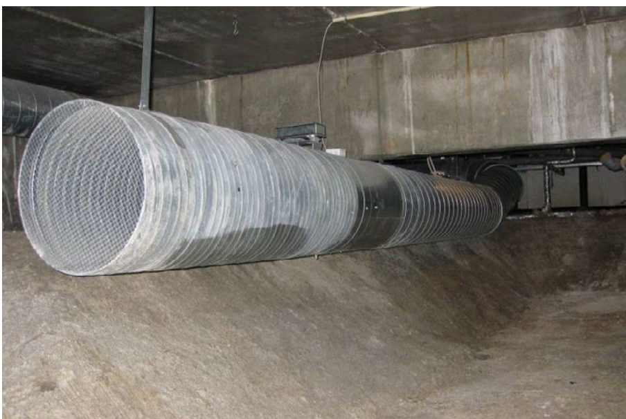
Figur 63. Krybekælder, kanaler i krybekælder.
