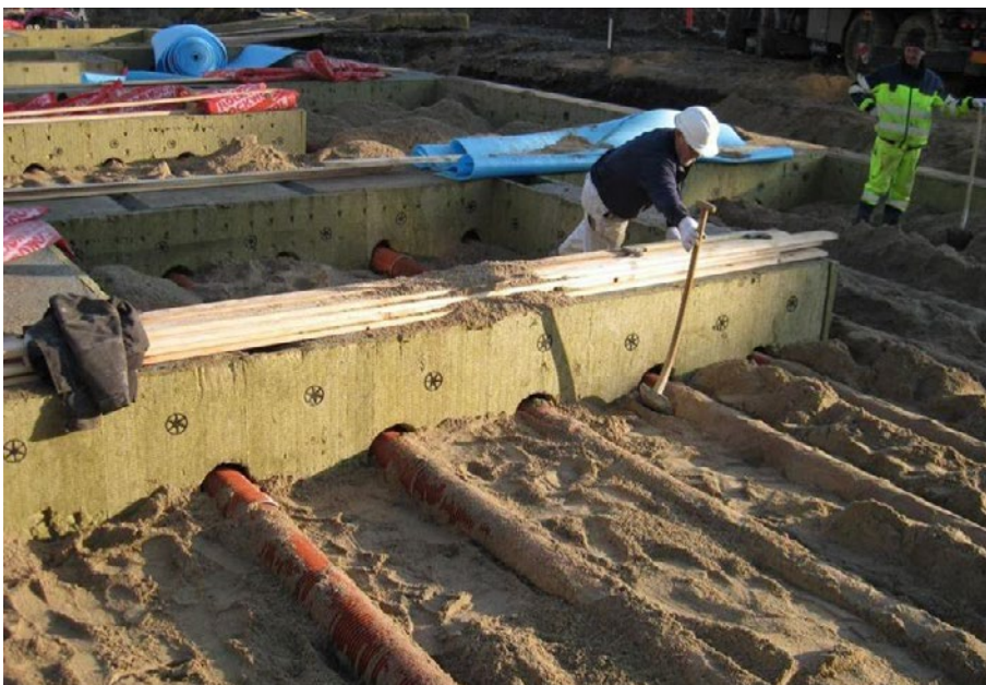
Figur 19. Etablering af kanaler under bygningen. (Bo Christensen)
