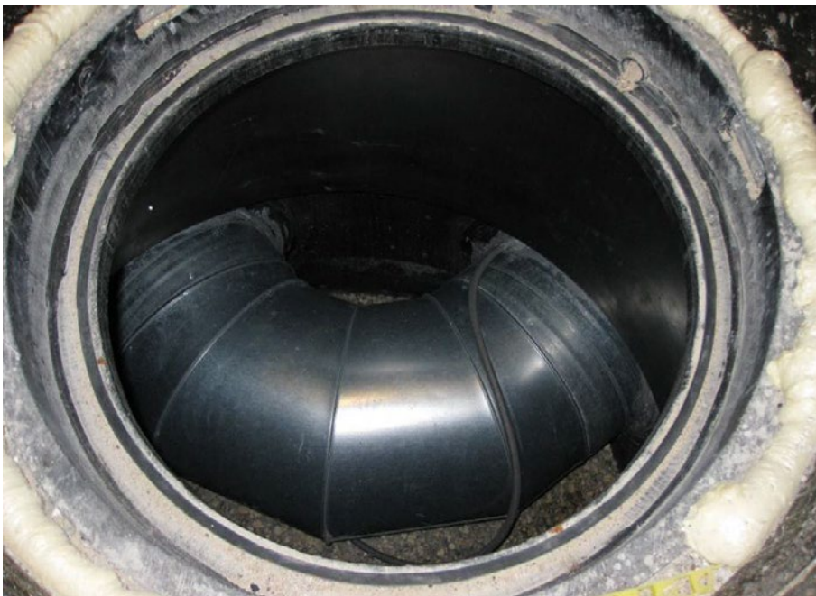
Figur 12. Kondensbrønden i bygningens vestlige ende. Kanaltilgangen "fra NV" er forbundet med filtersektion og udeluftindtag i bygningens vestlige ende, se figur 8 og figur 9. Kanalafgangen "mod NØ" går til kanalerne, som fører ind under bygningen, se figur 6.
