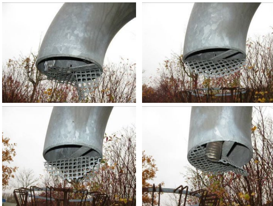
Figur 70. Vestside. Udeluftindtag.
