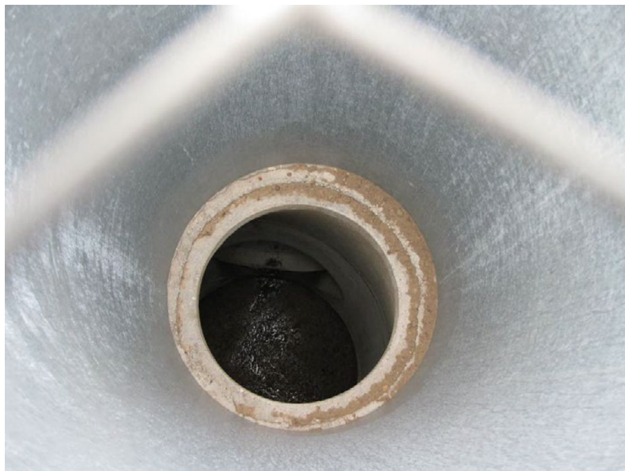
Figur 26. Kig ned i indtagskanalen.
