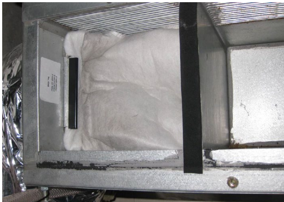
Figur 45. Filter i udeluftindtaget, monteret.
