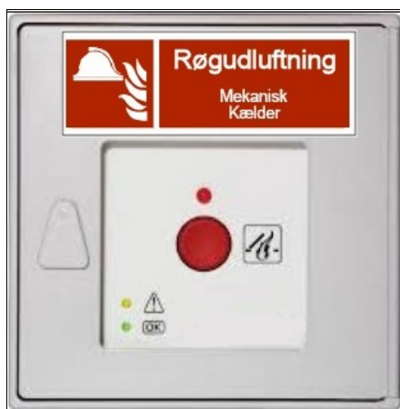
Figur 5.8.4.a: Eksempel på aktiveringstryk for røgudluftning
